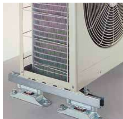
Soportes insonorizados para agregados
