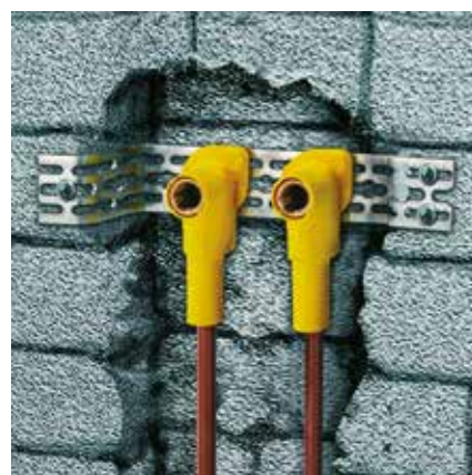
Instalación de lavabos: Fijación en paredes irregulares
