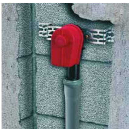
Instalación a la pared: Instalación de tubos de desagüe para lavadoras
