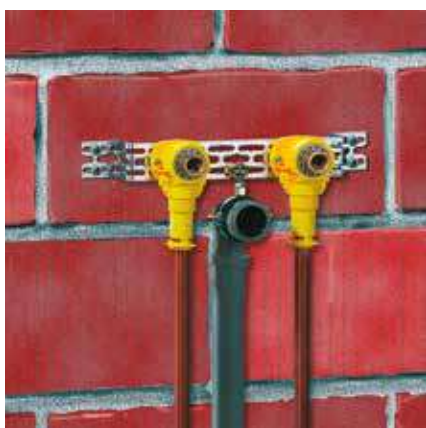
Instalación de lavabos: Instalaciones fijadas con exactitud
